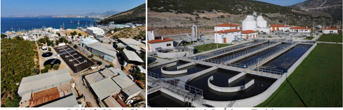
Şekil 13: Muğla Konvansiyonel Atık Su İşleme Tesisi
