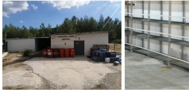
Şekil 12: Tehlikeli Atık Deposu
